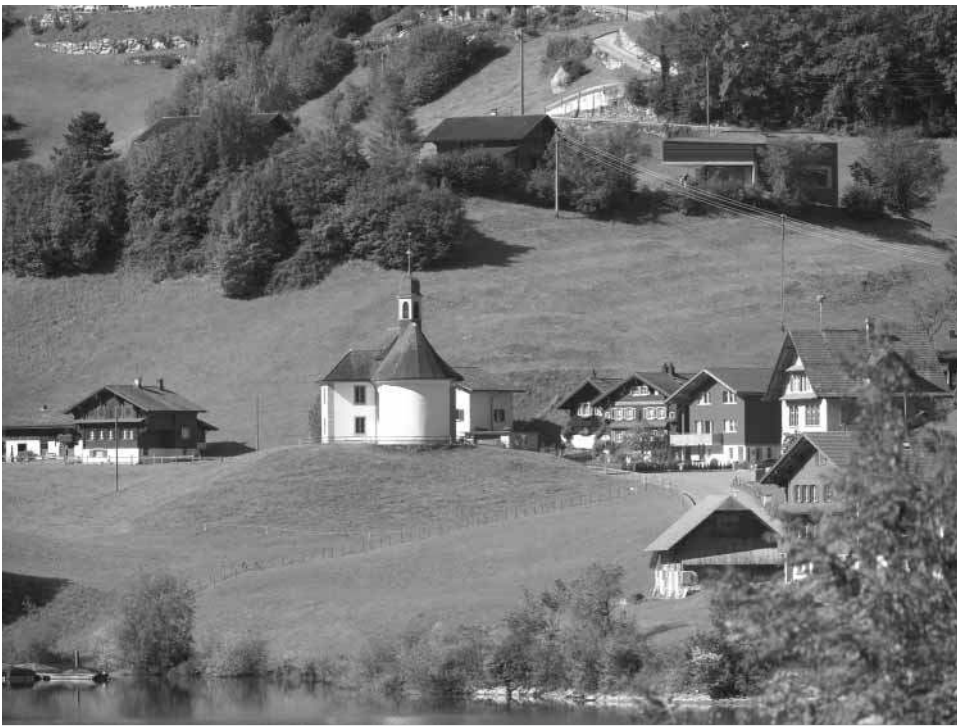
Das 2007 oberhalb des Lungersees erstellte Einfamilienhaus fügt sich sensibel und unauffällig in die bestehende Situation ein. (Foto Marco Hönninger, Luzern)
