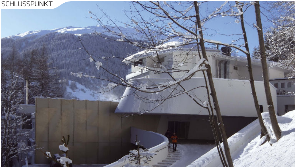
Die bescheidene Eingangssituation an der Rückfassade des Gebäudes entspricht nicht einem 5-Sterne Hotel.
