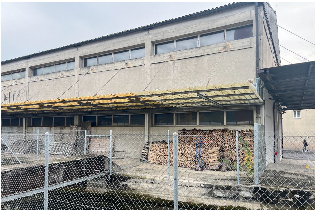
Abbildung 5 Blick vom Kanal auf das Gebäude D mit Beton-Tragstruktur und Fensterbändern, Fabienne Ottiger, 16.10.2023
