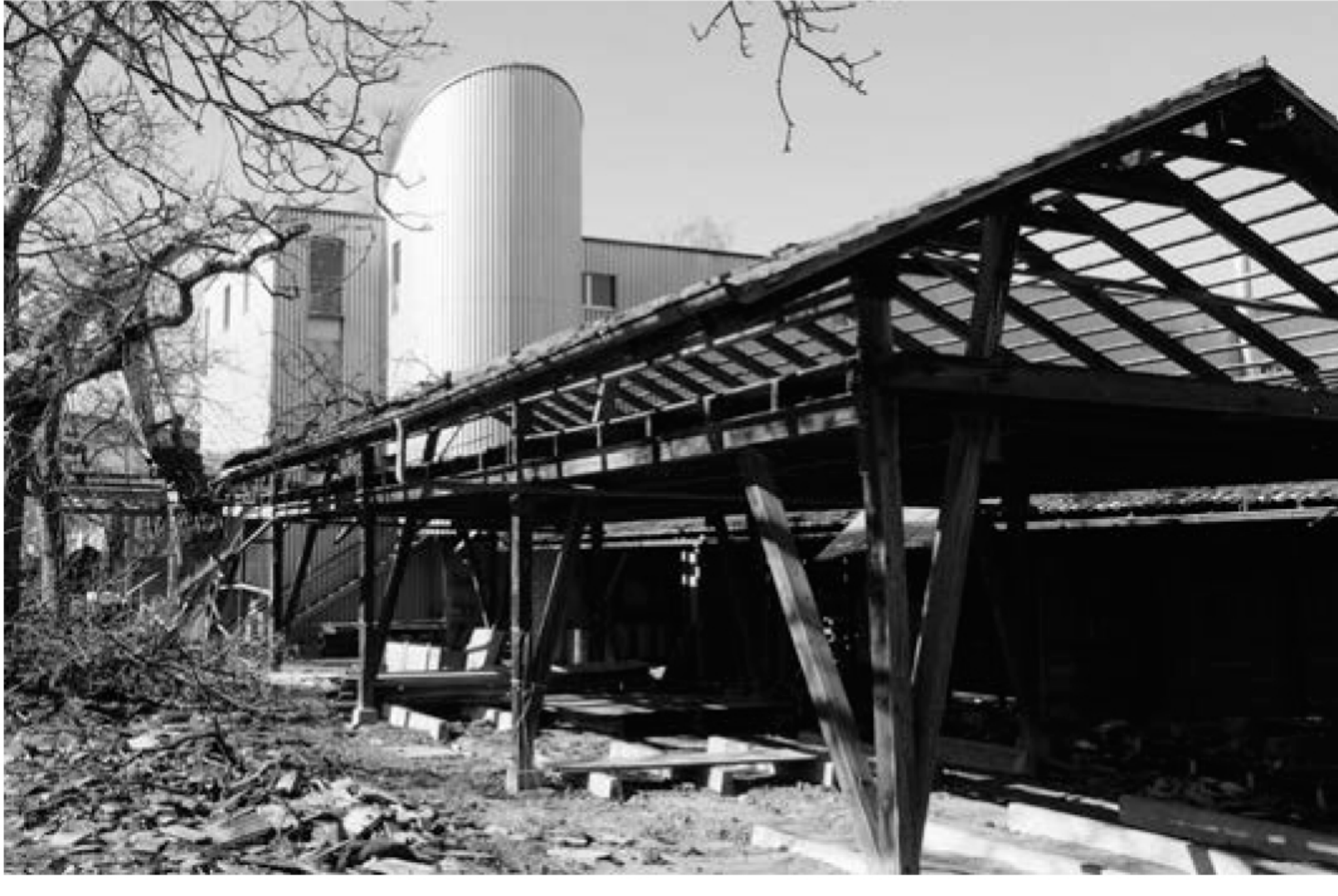
Auch beim Rückbau der bestehenden Holzlager stand der Fokus auf der bestmöglichen Wiederverwertung der Materialien.
